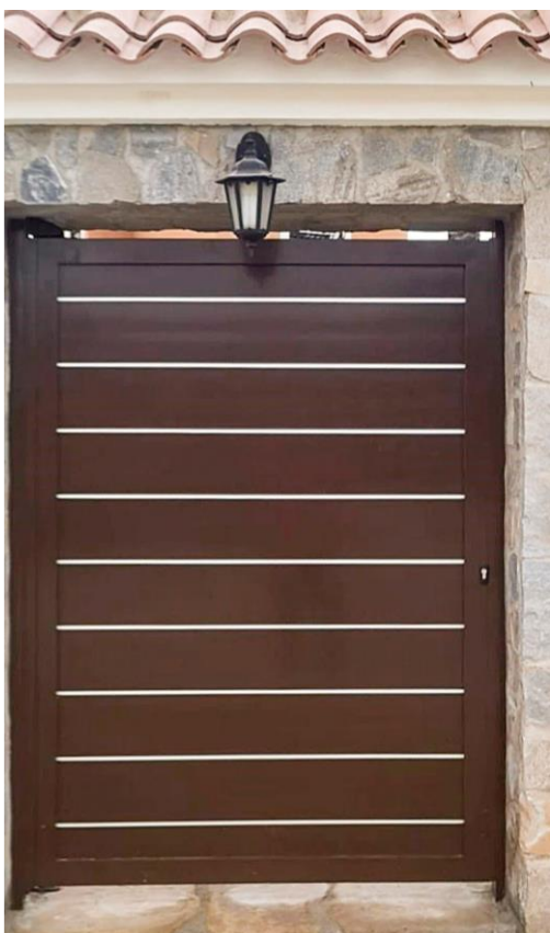
Lama recta de 140, incrustaciones en aluminio anodizado plata Marco 80x80.
